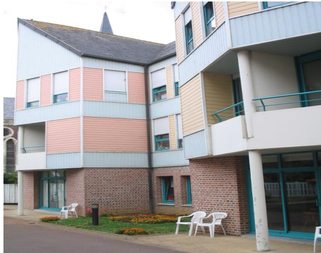
Centre Hospitalier « Foyer de Vie Philippe DESCAMPS » Rue du Fort Gassion
